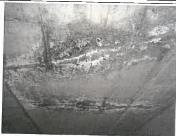
Cu0 Culée côté Bex T2110 Fissures importantes supérieures à 0.3 mm Dalle du couloir de visite, côté gauche. Fissures longitudinale avec traces d'humidité et efflorescences (2x).
