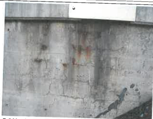
CuDr6 Mur de culée droit Massongex
