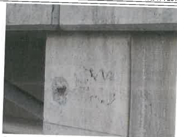
CuDr6 Mur de culée droit Massongex
