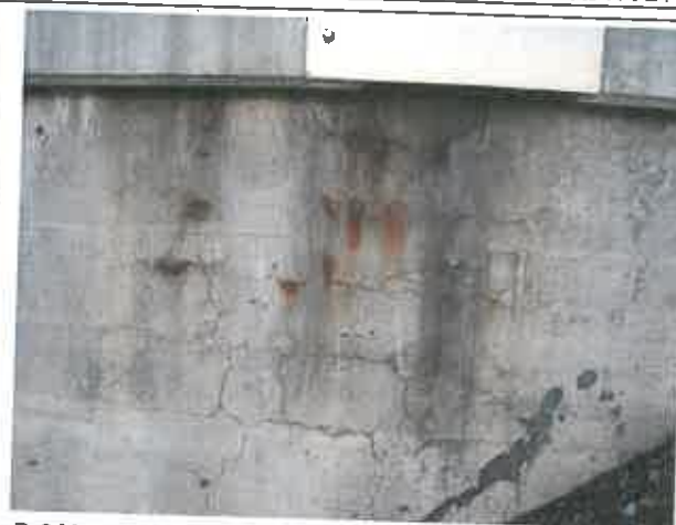
CuDr6 Mur de culée droit Massongex
