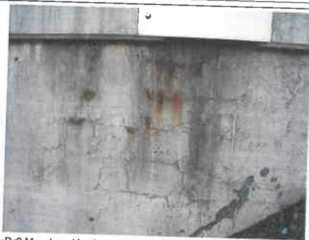
CuDr6 Mur de culée droit Massongex
